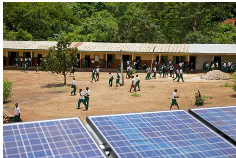
Panneaux solaires sur le toit d'une école Crédit photo : Power for all
